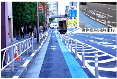
自転車専用通行帯の整備区間にゴム製ポールと貨物車専用駐車枠を設置(東京都港区)
