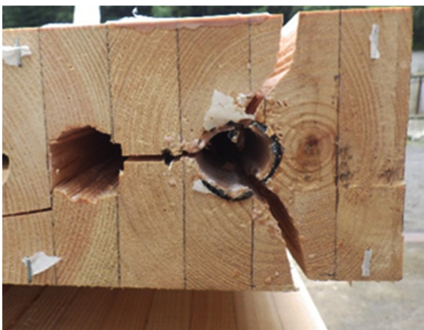
木材の割裂破壊
