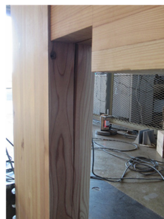
写真 2 柱材断面中央部からの割裂
