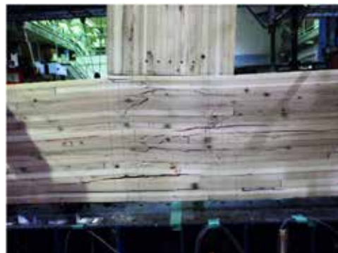
パネルゾーンのせん断破壊と割裂破壊
