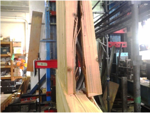
梁側の割裂破壊 No.3
