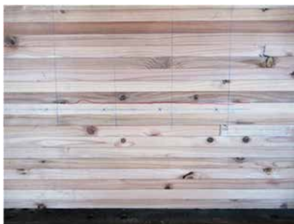
写真 4 LSB の引き抜け力と押し抜き力による柱部材 中央部のせん断割れ（S2-750-02）
