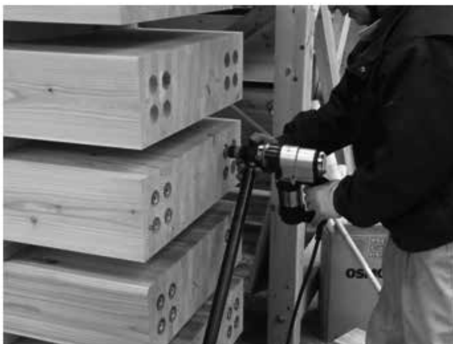
写真 1 LSB の施工状況
