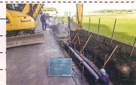
湊幹線水路（管敷設状況）
