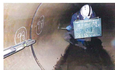
試験通水前の管内調査
