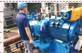
柳沢機場（ポンプ工場検査）
