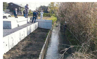
堤分水工から新川への注水
