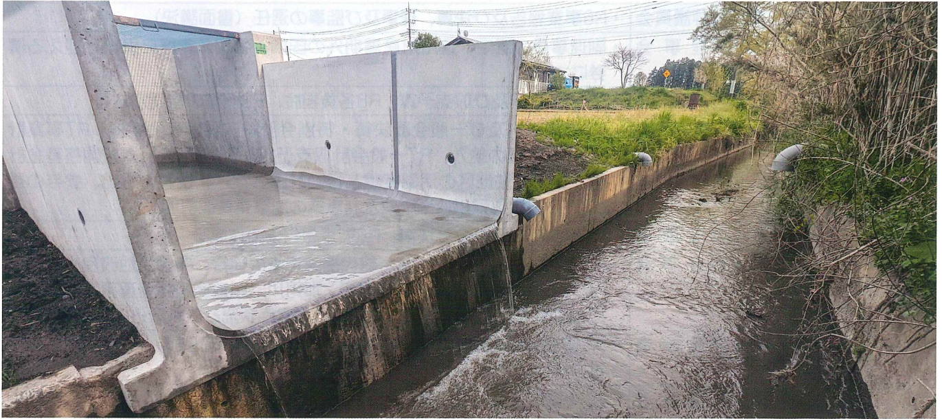
国営水那幹線堤分水工（新川試験放流）：那珂市堤
