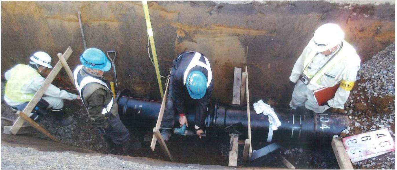
国営小野幹線(新設)管水路工事：常陸大宮市小野
