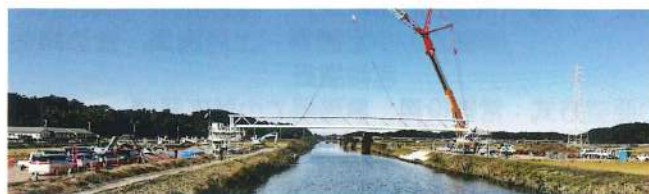
国営湊幹線水路 水管橋の架橋工事状況
