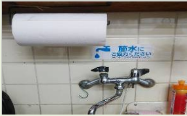
水使用場所に節水プレート設置
