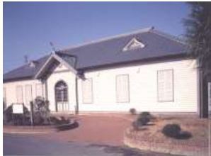
▲千代生誕の地 日本煉瓦製造(株)跡地 現在の資料館
