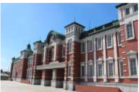
東京駅を模してレンガ調の造りで改築された JR 深谷駅
