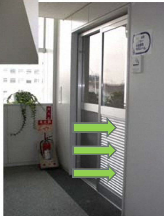
入り口にガラの設置
