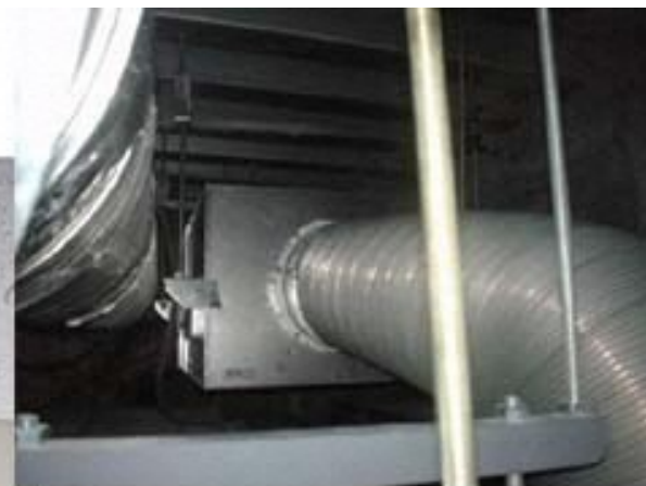
天井裏に排気装置を増設
