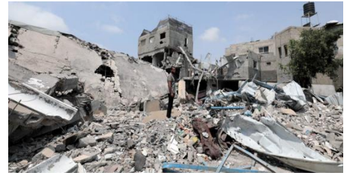
破壊されたガザ市街
