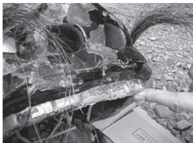
図10 塩害、鉄釘の錆
