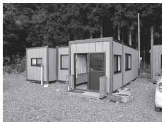
図 25 観音寺仮本堂
