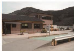
40t トラックスケール
