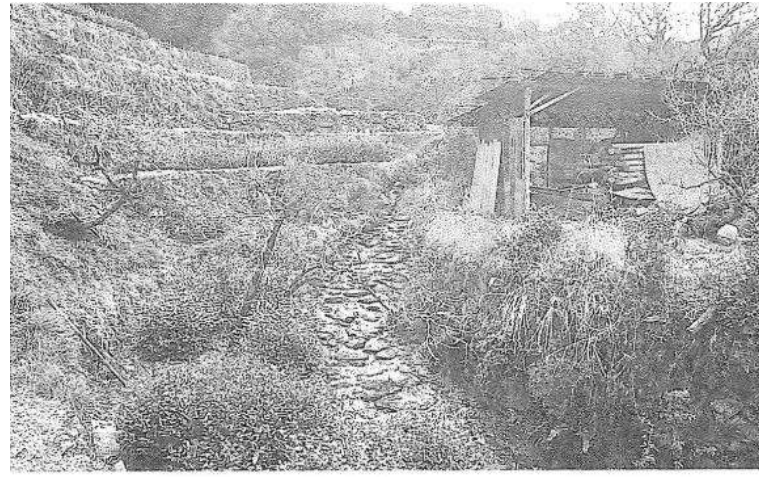
写真一 6 花巡廻水路 (落水部石張り)
