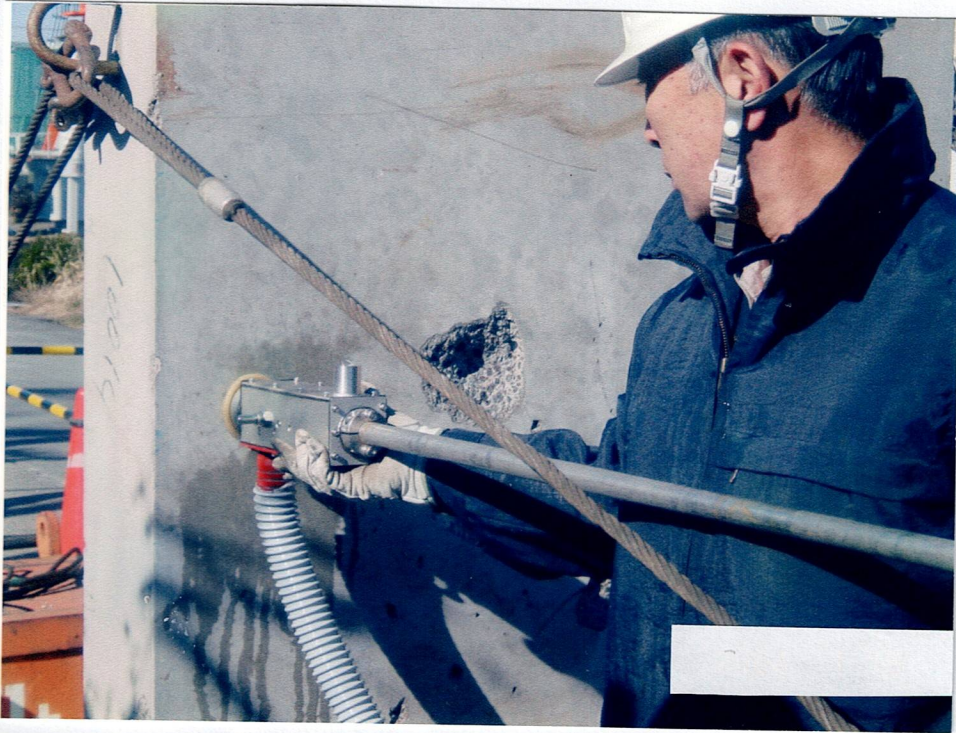
写真②-③ ズルヘッドの遮蔽版にリンクの押しボタンを強制的に押し WJの噴射状況をテスト中。
