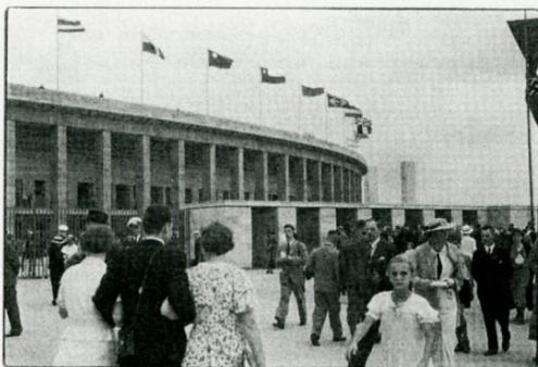
国立競技場の外観。全長 300 m、幅 230 m の楕円形。トラックからの高さは 30 m だが、半分地下に埋まっているので外観の高さは 15 m に抑えられている。
