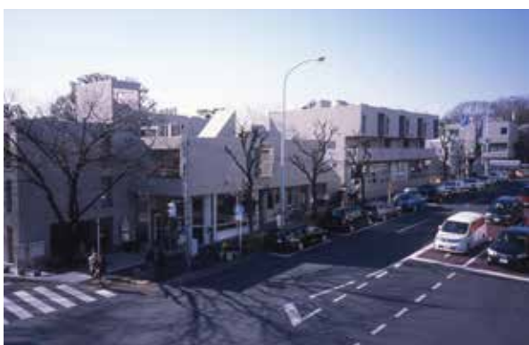
東側の今はない歩道橋から見る第一期の外観 二〇一〇年
