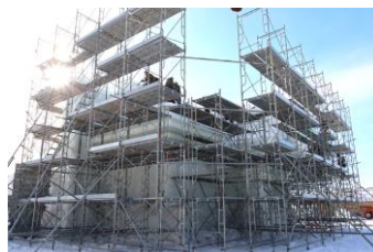
製作中の全景
