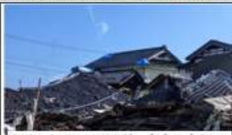
倒壊したままの建物が、あちこちに・・
