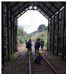
▲駅から少し離れたところにある線路の雪囲いです。この線路は駅に発着する列車がいったん引き上げるスイッチバックの部分にあり、除雪が入れないことからこのような雪囲いが設けられています。
