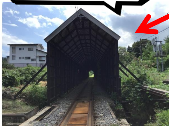
▲駅から少し離れたところにある線路の雪囲いです。この線路は駅に発着する列車がいったん引き上げるスイッチバックの部分にあり、除雪が入れないことからこのような雪囲いが設けられています。
