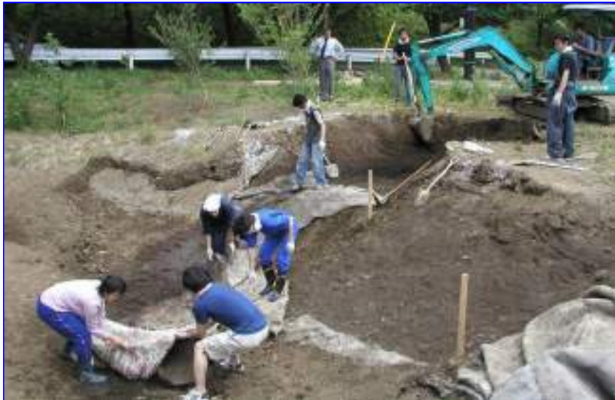
みんなで穴掘り・ビオトープ池作り
