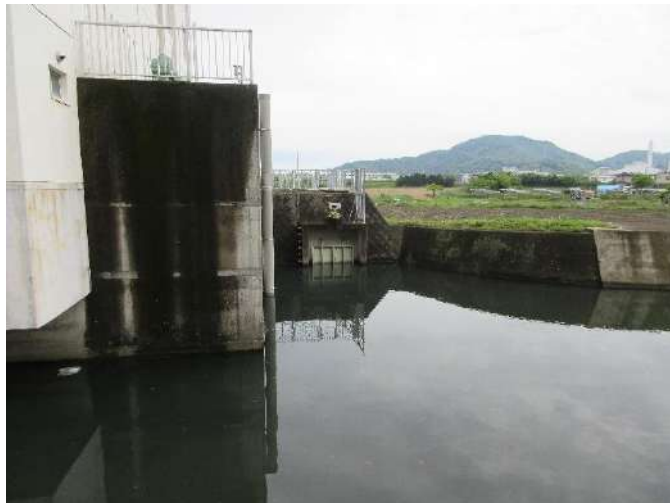
写真Ⅲ-4 大廻塘の右樋門の箇所と一致する、満潮時の排水の調整機能を果たす遊水地への樋門。
