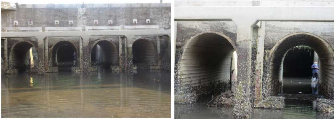
写真図Ⅲ-20、21 百間樋門の 4 連アーチ、樋門のトンネル内は金属版？で被覆されているが、その内部が石積みの可能性もある。
