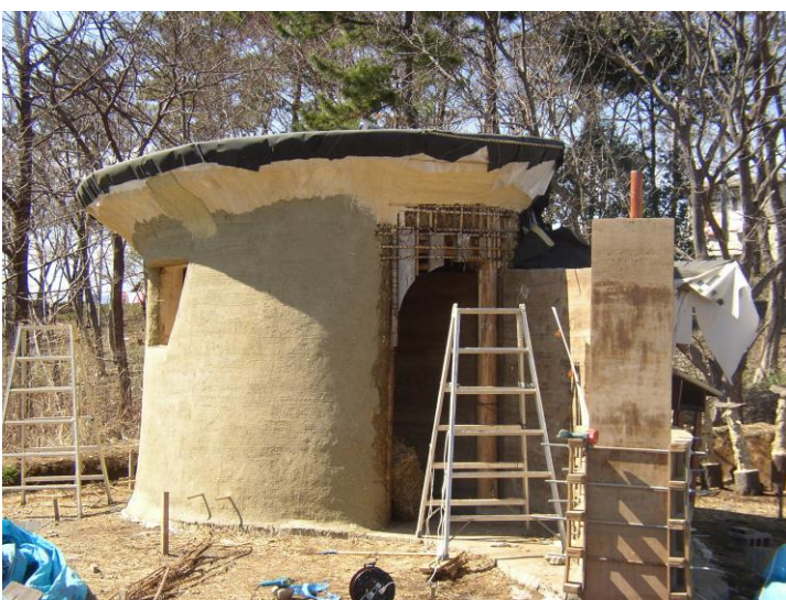
写真 日本大学生物資源科学部生物環境科学研究センターでのストローベイルと土による自然建築づくりワークショップ
