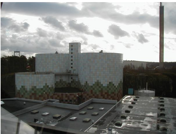
写真 イエテポリ市の下水処理場。 下水汚泥をバイオガス化して利用
