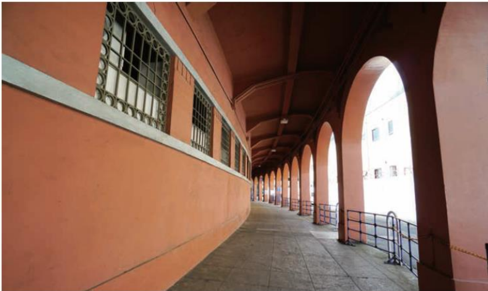
写真1 神宮球場のアーチ型の外壁 (写真=編集部)
