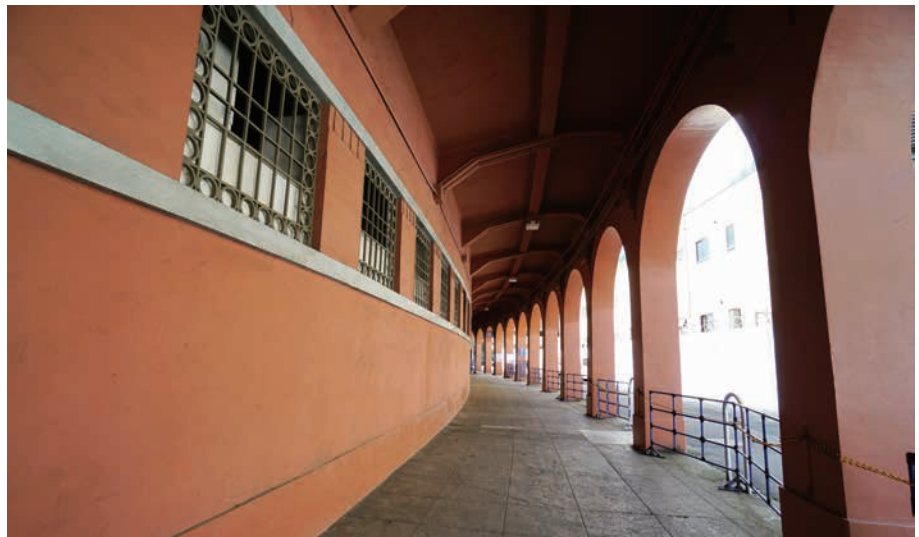
写真1 神宮球場のアーチ型の外壁（写真=編集部）
