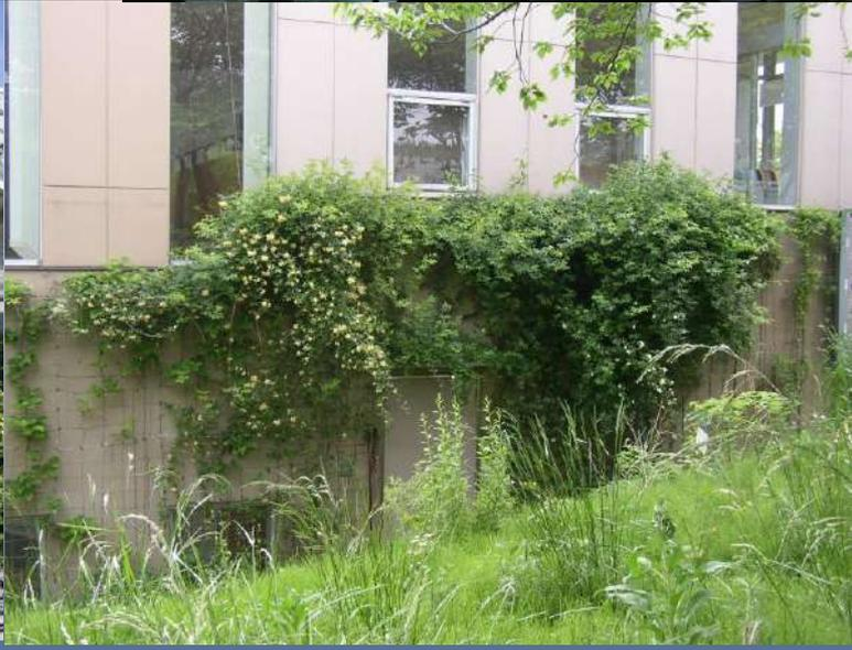
壁面緑化実験(パッシブプロムナード前南面のフジ、西面のツルバラ、東面のツルバラ・ブドウ)
