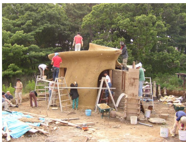
写真8 日大CNE S敷地内のストローベイル建築の自立建設ワークショップ
