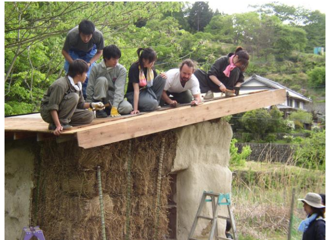
写真10 学生、環境市民参加によるPCCJ農場内でのストローベイル建築WS
