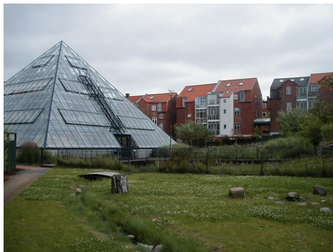
写真2 集合住宅中庭に設置された植物汚水浄化プラント (バイオワークス)
