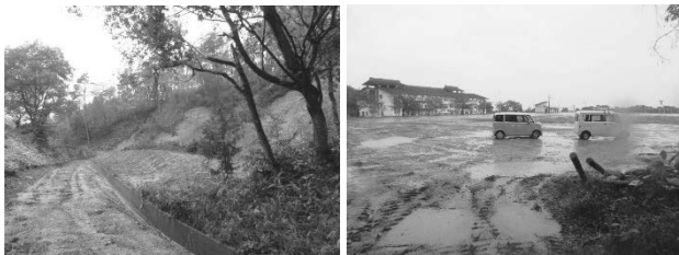
写真 13(左) 椿の丘陵部のため池下の水路沿い斜面崩落 写真 14(右) 写真 13の水路下流の被害地(中学校校庭)
