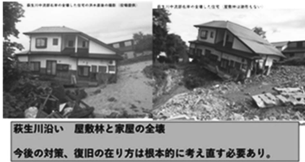
写真4 萩生川沿いの全崩壊した宅地と屋敷林
