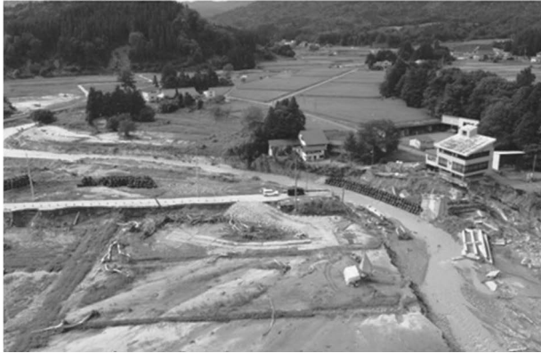
写真 10 小白川下流の崩落した大巻橋のドローン写真
