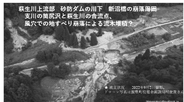
写真3 萩生川上流右岸支川との合流点の惨状
