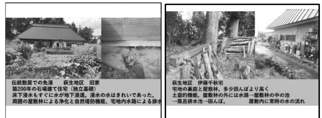
写真17 萩生地区の伝統的散居住宅(写真16の黄色点線枠)の石場建て基礎(免浸構造)、土塁の屋敷林、敷地内水路
