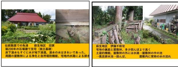
図 29 萩生地区の伝統的散居住宅(図 28 の黄色点線枠)の石場建て基礎(免浸構造)、土墨の屋敷林、敷地内水路
