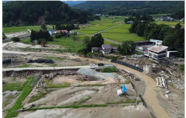
図 18 小白川下流の崩落した大巻橋のドローン写真
