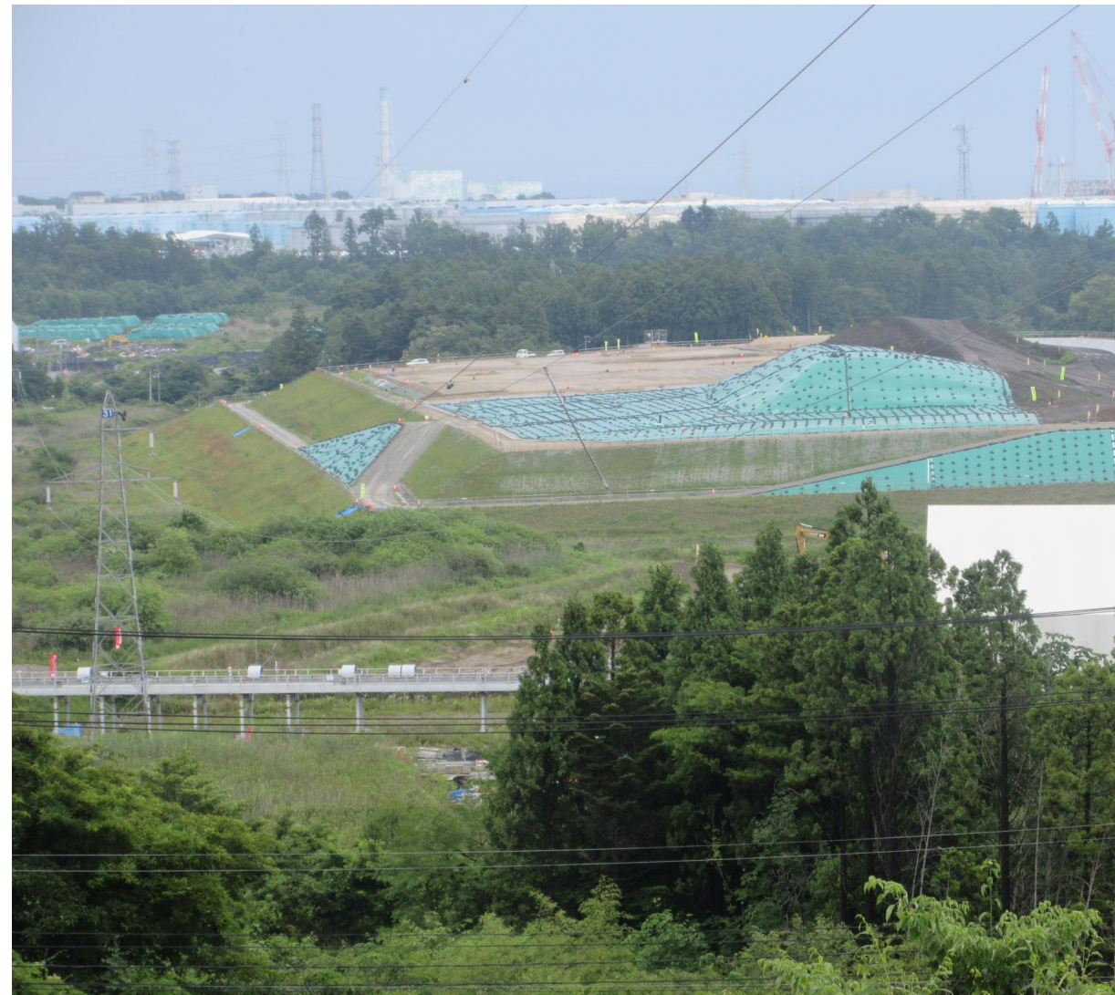
中間貯蔵地での汚染土壌埋 め立て 2023年6月
