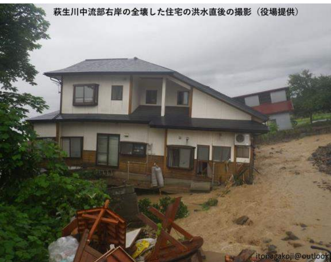
萩生川中流部右岸の全壊した住宅（屋敷林は跡形もない）
