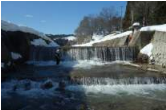
写真12 155cmの落差工
