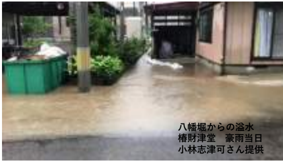
図 13 八幡堀からの溢水（駅からのT字路）
