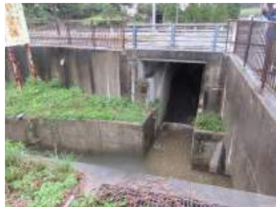
図 20 椿の県道沿いの交差点の下の八幡排水路と合流点
