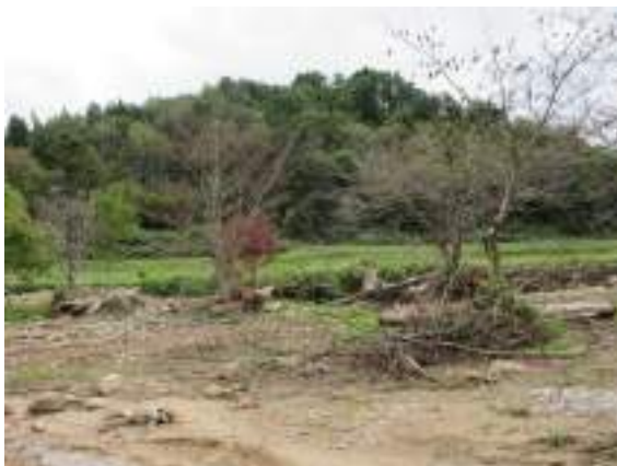
図9 萩生川上流左岸の流木堆積
