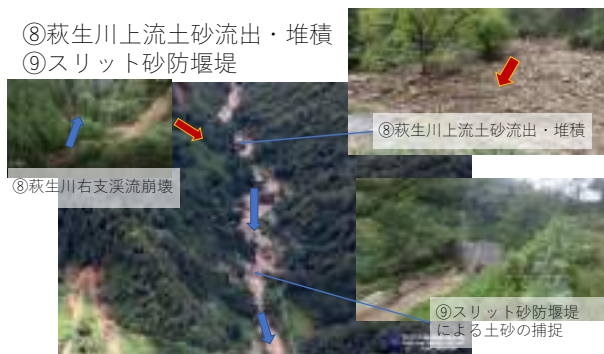
図3 萩生川上流部の土砂流出・堆積とスリット砂防堰堤
