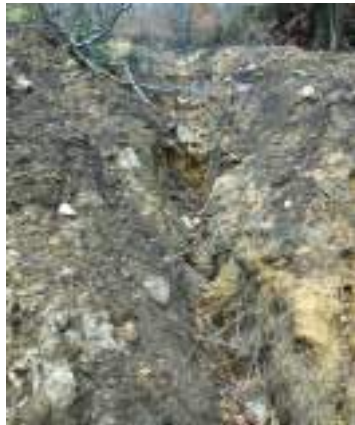
写真3 ガリ状の浸食溝
