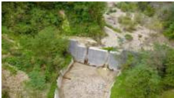
写真 2. スリットダム（10月19日11:45頃空撮）
