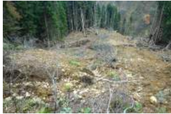
写真2 崩壊箇所の下部側
