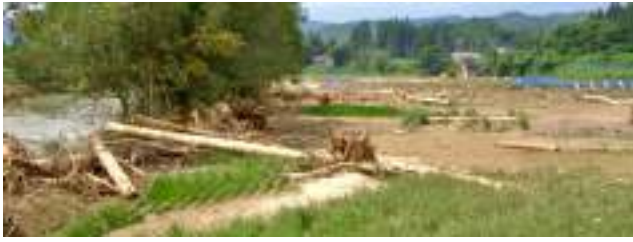
写真 53. 外記川原橋左岸（8月11日10:00頃）
