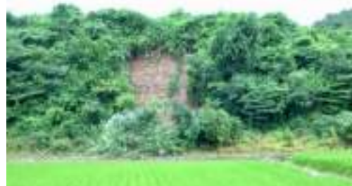
写真 52. 表層崩壊 (8月4日 15:55 頃)
