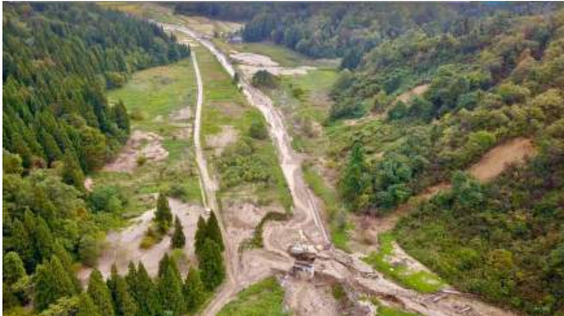
写真4. 新沼橋（中央下）から南高野橋（中央上）にかけての変状（10月19日11:45頃空撮）
