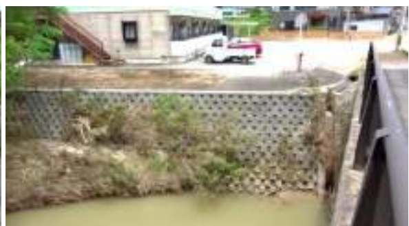
写真 60. 宇津川橋の上流（8月11日11:10頃）
