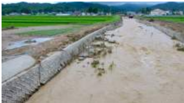
写真 11. 三谷橋の上流側 (8月4日 17:15 頃)
