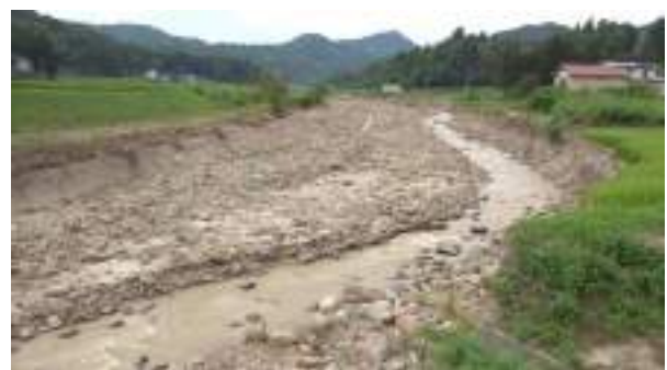
写真8. 諏訪橋の上流側（8月11日12:55頃）
