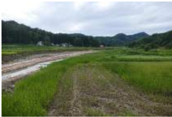
図7 萩生川中流右岸の圃場崩落
