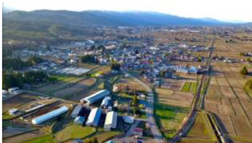
写真 50. 長瀬橋より北方を望む (4月23日 17:30 頃空撮)
