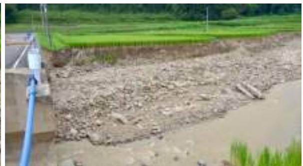
写真6. 弥五郎橋. 右岸の侵食（8月11日12:30頃）
