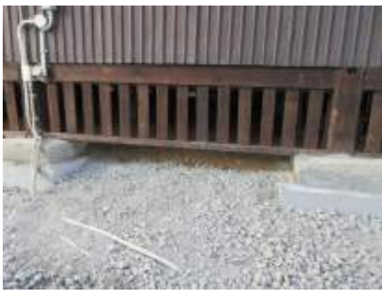
図 17 大福寺の石場建の本堂の床下
