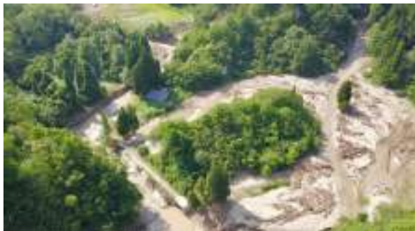
写真 31. 林道の流失（8月7日 14:00 頃空撮）
