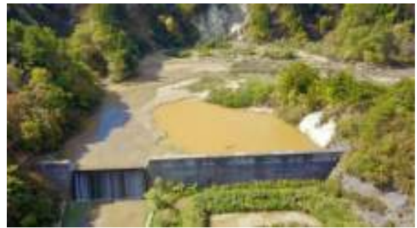
写真 32. 砂防ダム（8月11日 14:25 頃空撮）
