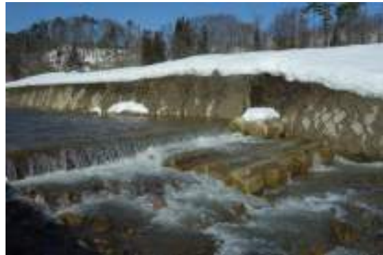
写真13 落差を緩和するコンクリート構造体
