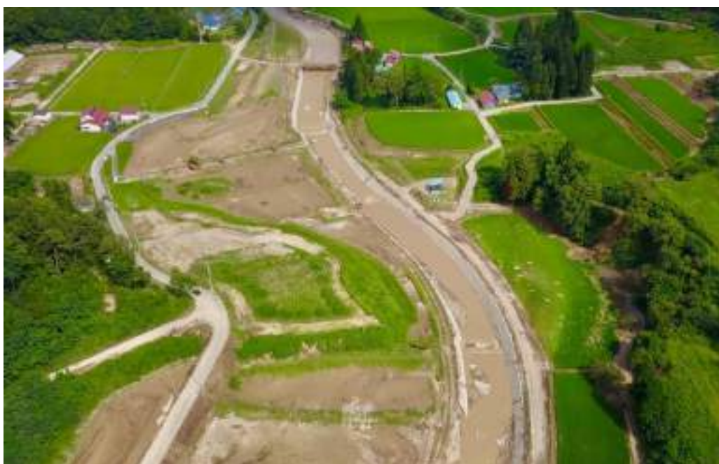
写真 33. 芋元付近。竹原橋から下流を望む。中央上に芋元橋（8月7日 14:25 頃空撮）
