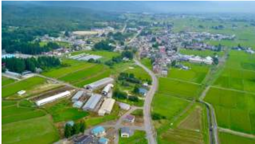
写真 49. 長瀬橋より北方を望む (8月11日 7:50 頃空撮)
