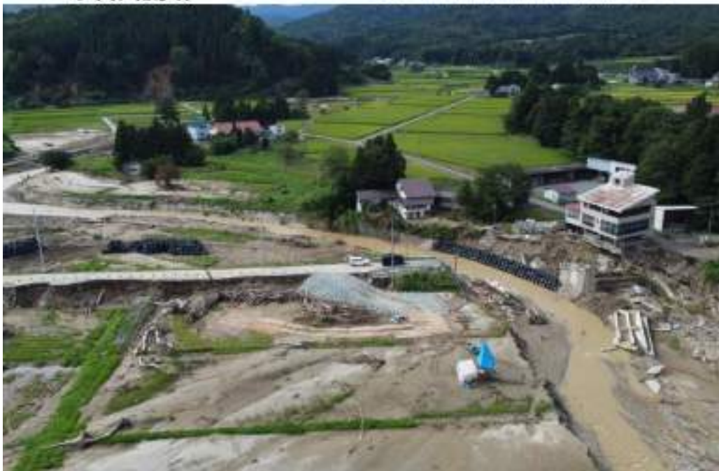
図 34 大巻橋周囲の被害状況
