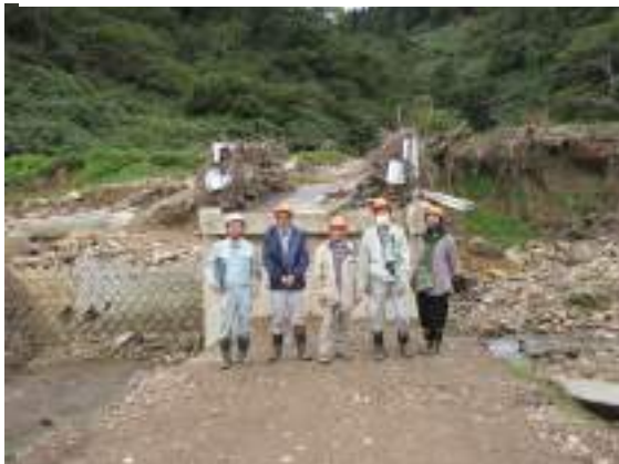
図3 2022年10月7日の調査研究チーム の現地調査 萩生川 新沼橋
