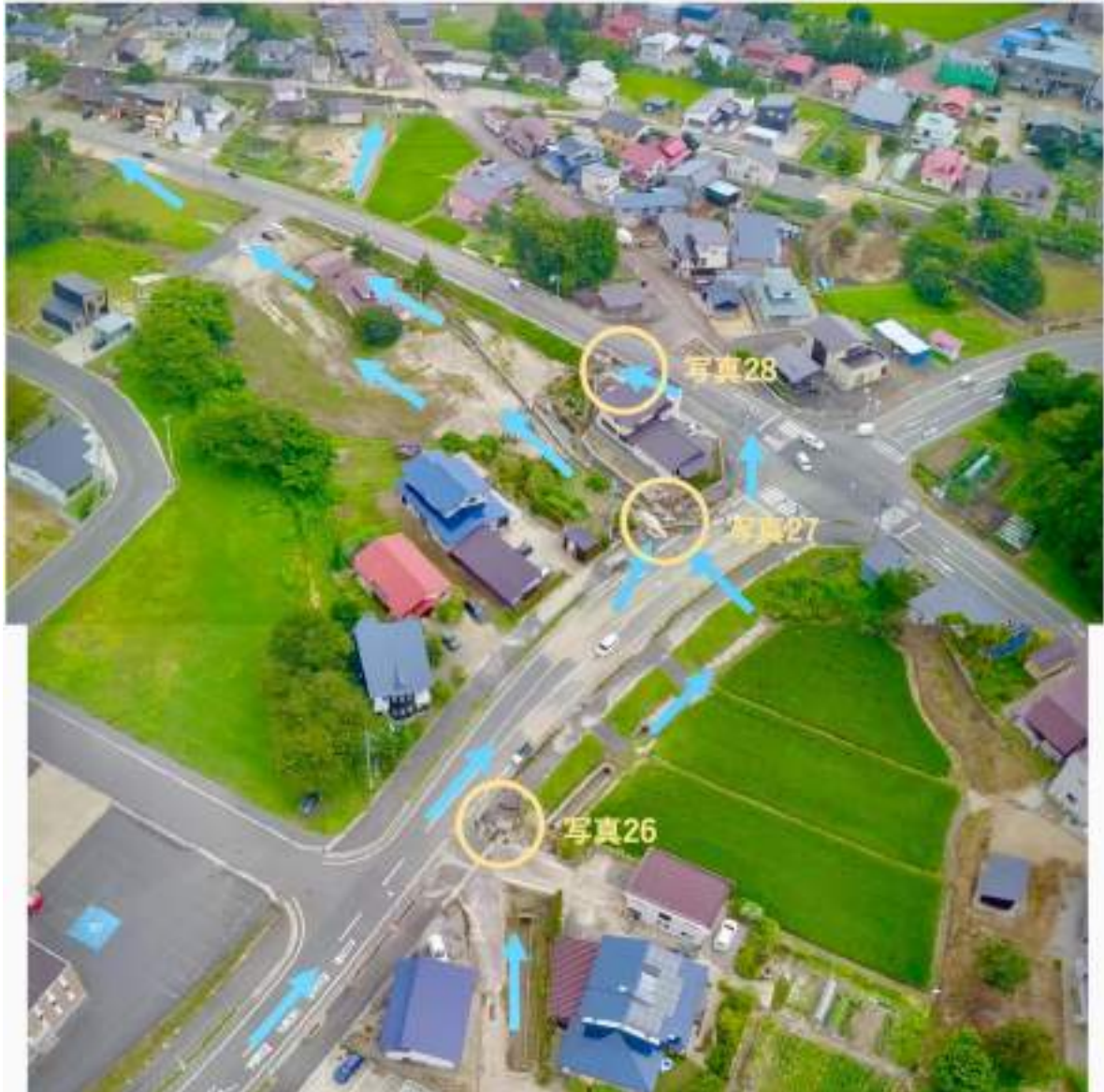
写真 24. 椿地区の柳沢排水路。消防署付近から東方を望む（8月7日 11:00 頃空撮）
