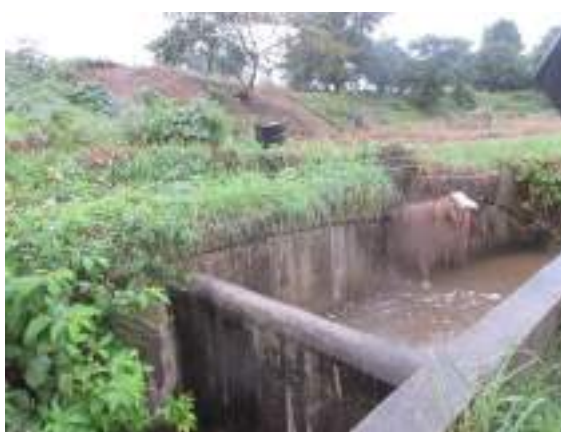
図 22 八幡排水路の西で封鎖された壁
