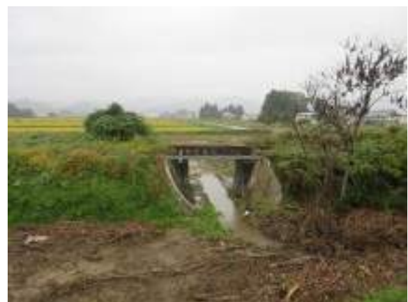
図11 萩生川の鉄橋横の鉄橋下水路
