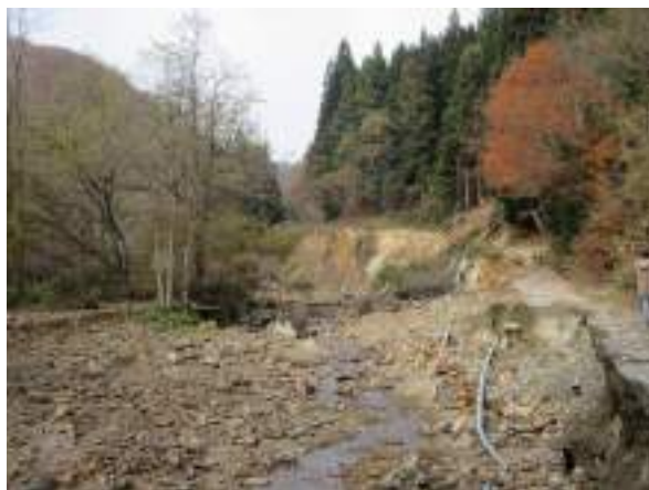
図1 萩生川上流(砂防堰堤の上流)の崩落
