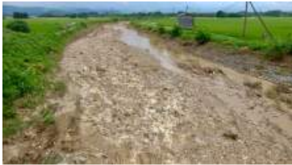
写真 17. 黒沢橋の下流側 (8月11日 12:20頃)
