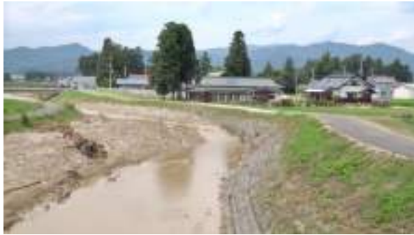
写真 15. 黒沢橋の上流側 (8月11日 12:20頃)
