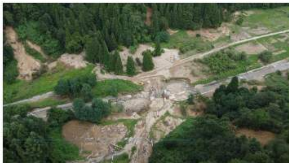
図3 新沼橋の周囲に堆積した土砂と流木、図1の崩落森林からの流木土砂
