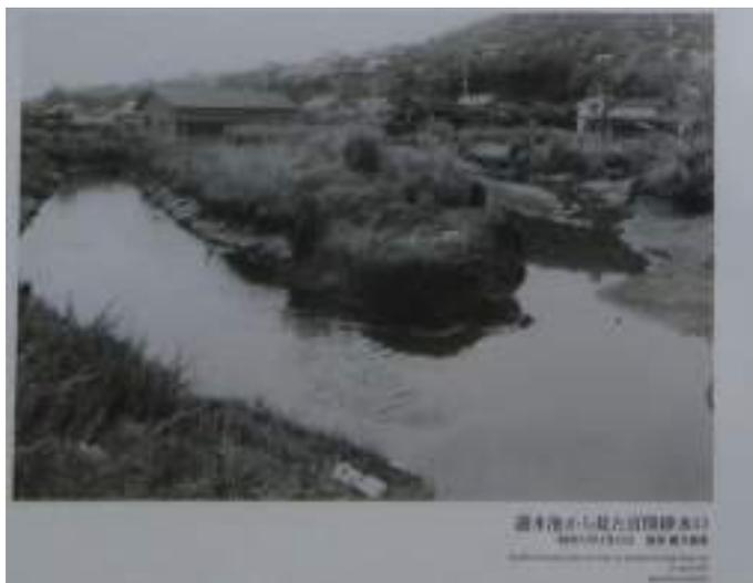
上の図と写真 1970年代の百間排水口の工場内の排水の遊水地。奥にポンプ小屋が見える。
