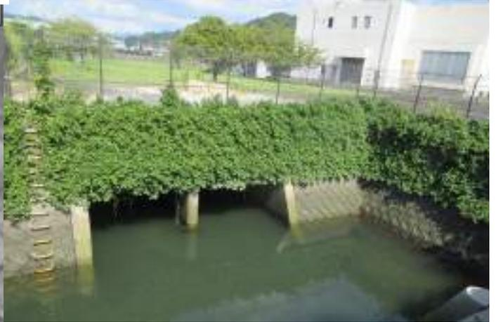
写真 1999年の排水口の新設と樋門の手前に貯水池（沈殿池？）を設置？ 後方にはかつての排水遊水地を埋めて芝生が増設。1999年の整備時の図面、写真（整備前後）が必要（水俣市保有か）
