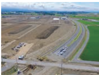
（表紙写真） 国営旭東東神楽地区の工事状況 （ほ場整備と空港への道路工事）
