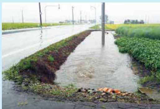
H28.8.20 西4号道路沿 東側排水路
