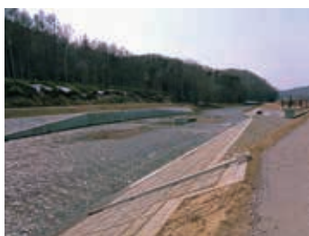
(表紙写真) 更新された豊田頭首工 (上流より)
