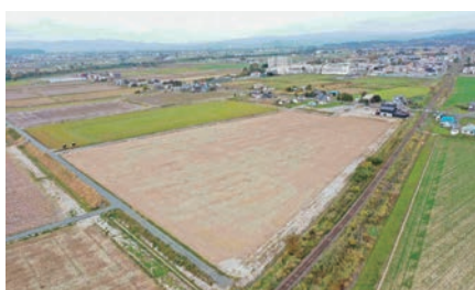
（表紙写真） 道営兵村北地区の工事状況
