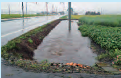
西4号道路沿 東側排水路
