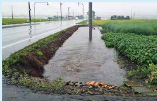
西4号道路沿 東側排水路
