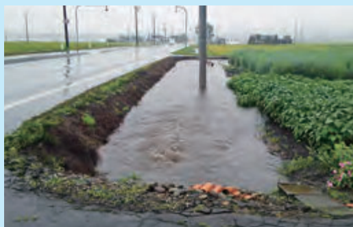
西4号道路沿 東側排水路
