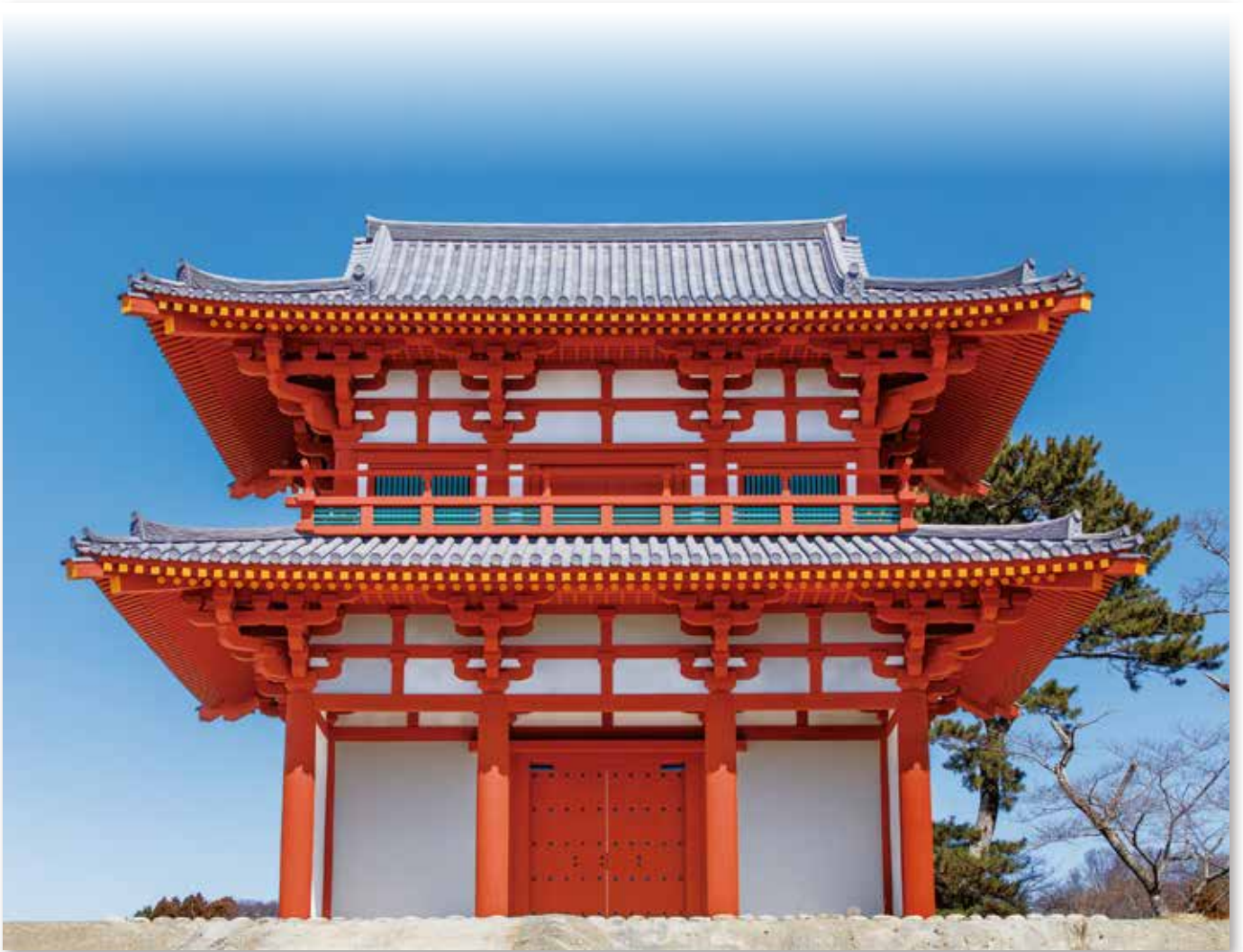
復元工事中の多賀城南門
